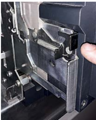
Figura 21 - Trava de destrave do disjuntor extraível
