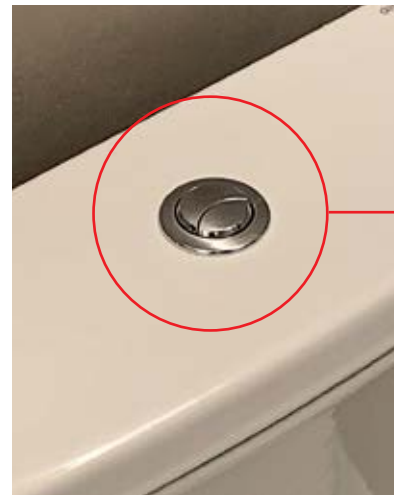
Foto 03 - Vaso com Acionador Duplo de Caixa Acoplada.
