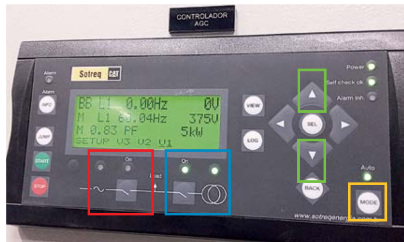
Figura 55 - Controlador AGC em operação modo rede concessionária
