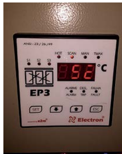
Figura 36 - Relé de alarme e temperatura trafo 05
