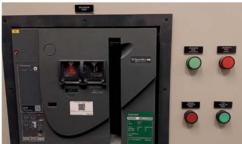
Figura 53 - Disjuntor Rede QTA Sotreq
