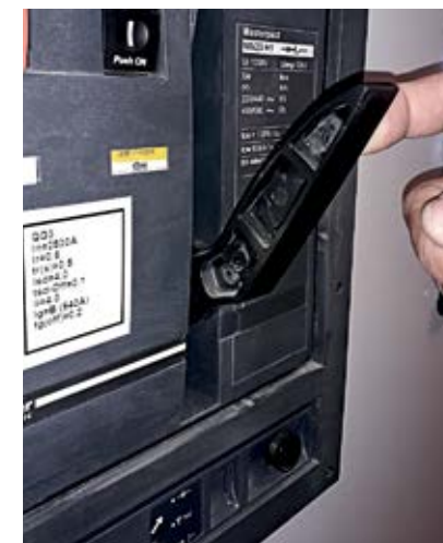
Figura 17 - Movimento para carregamento da mola.
