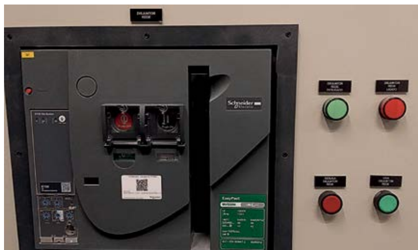
Figura 57 - Disjuntor Rede QTA Sotreq
