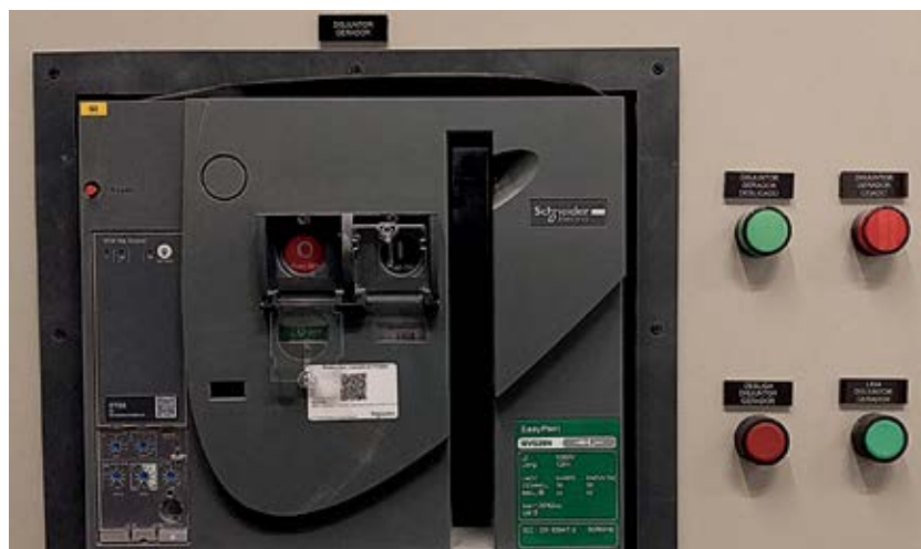
Figura 56 - Disjuntor gerador QTA Sotreq
