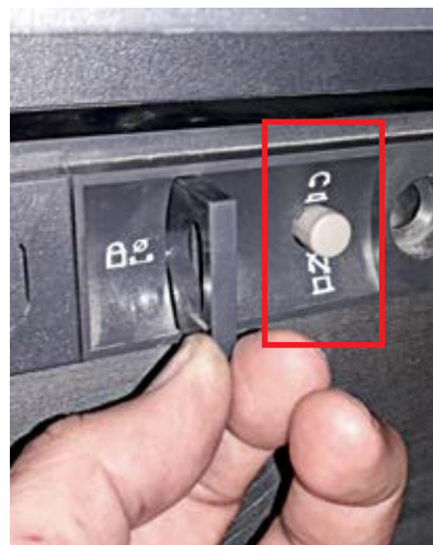
Figura 23 - Botão de destrave do acesso da alavanca de extração
