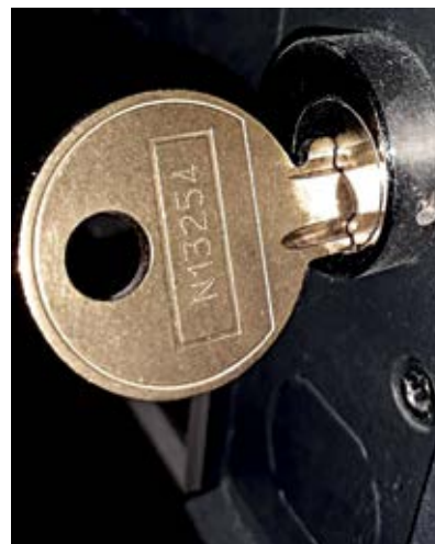
Figura 15 - Chave de bloqueio dos disjuntores
