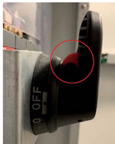
Foto 03 - Trava da Chave Seletora de Rede.
