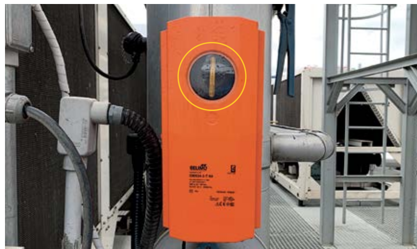
Atuador da Válvula do Chiller 01, 02 e 03 - Válvula Aberta
