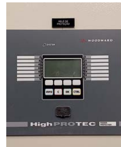
Figura 51 - Relé de proteção do QTA
