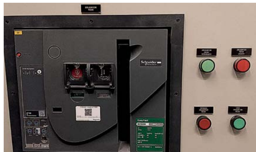
Figura 58 - Disjuntor rede no QTM-1
