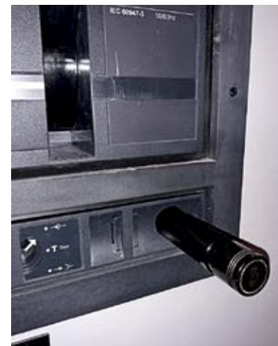
Figura 24 - Alavanca para retirada de sua base
