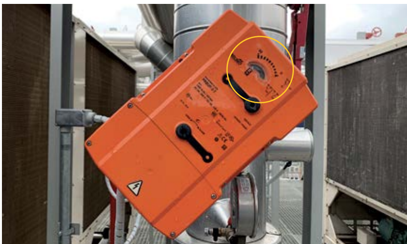
Atuador da Válvula do Chiller 04
