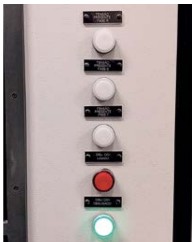
Figura 29 - Exemplo de identificações da presença de tensão e de acionamento de disjuntor (Disjuntor desligado)
