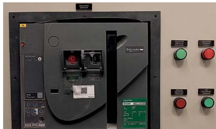
Figura 52 - Disjuntor gerador QTA Sotreq
