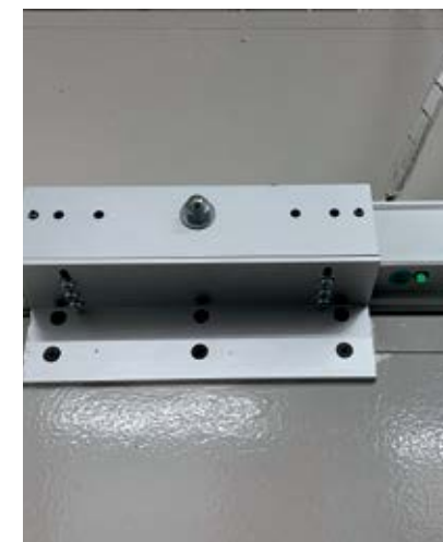
Foto 04 - Fechadura Elétrica.
