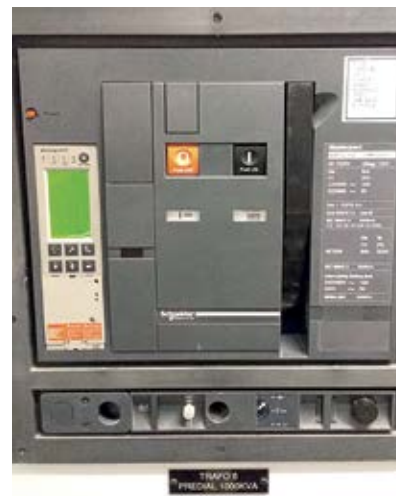
Figura 5 - Disjuntor 06 Trafo 5 Predial 1000kVA
