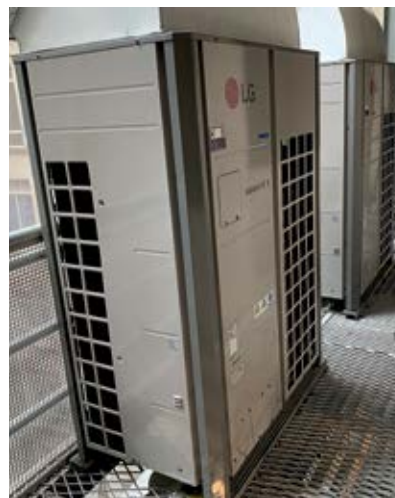
Foto 01 - Condensadora.
