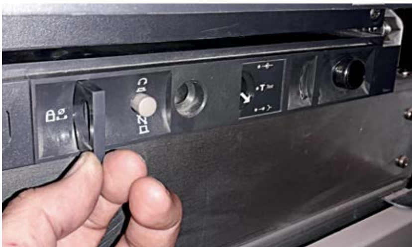
Figura 27 - Procedimento para instalação de cadeado no disjuntor.
