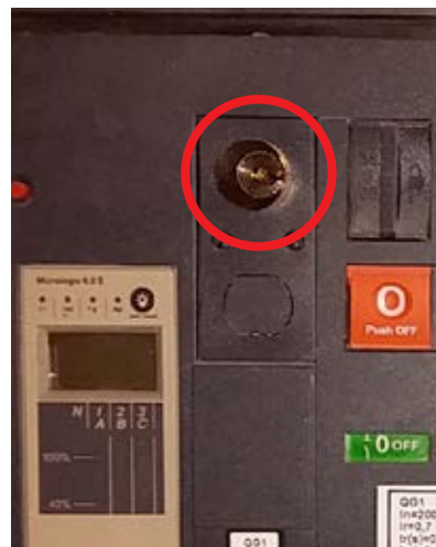
Figura 45 - Chave Kirk posição desligada (OFF)
