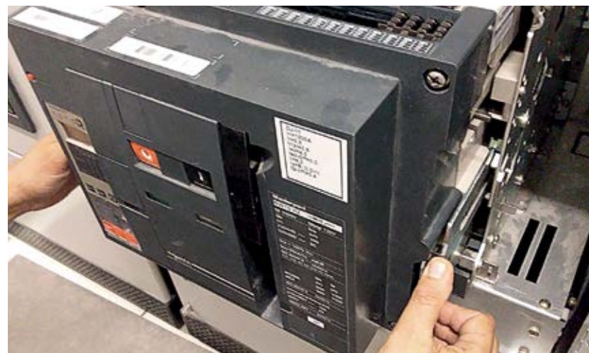
Figura 19 - Posicionamento após a extração
