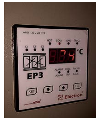
Figura 37 - Relé de alarme e temperatura trafo 01
