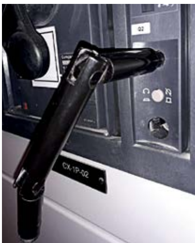
Figura 25 - Instalação da alavanca para acionamento do destrave
