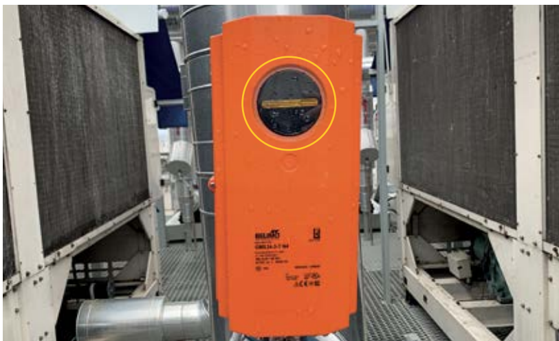
Atuador da Válvula do Chiller 01, 02 e 03 - Válvula Fechada
