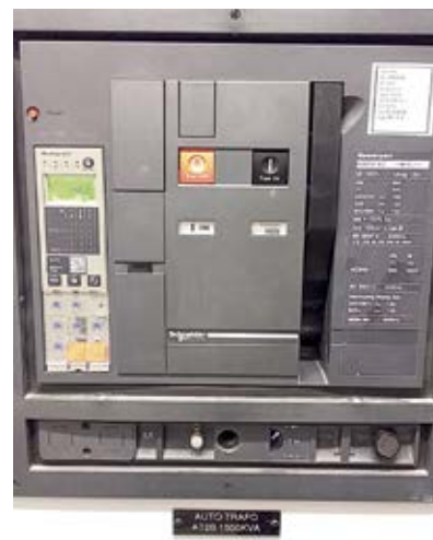
Figura 7 - Disjuntor 08 Auto Trafo AT 2B 1500kVA
