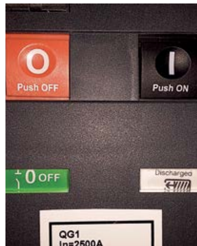
Figura 13 - Disjuntor desligado (Off verde) e mola descarregada (Discharged branco)
