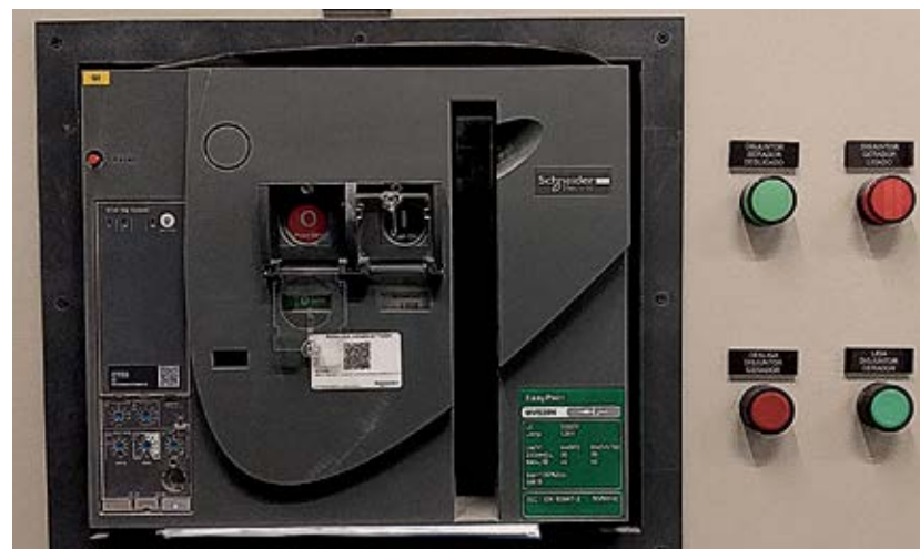
Figura 61 - Disjuntor de rede p/ bypass no QTM-2
