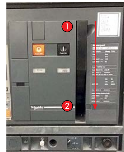
Figura 16 - Carregamento da mola para ligação do disjuntor.
