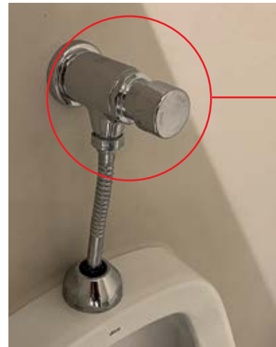
Foto 02 - Mictório com Temporizador de Fluxo.
