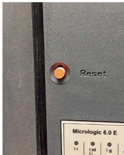
Figura 22 - Botão Reset no disjuntor
