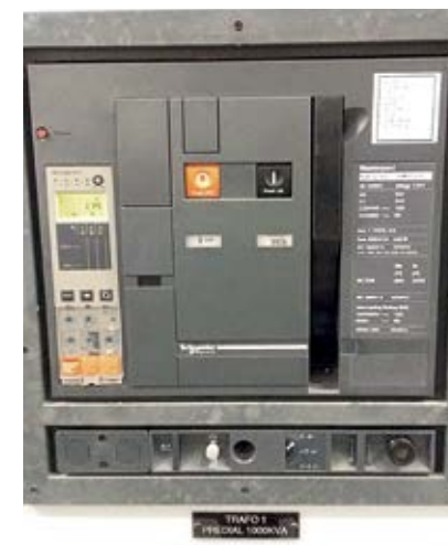
Figura 8 - Disjuntor 09 Trafo 1 Predial 1000kVA
