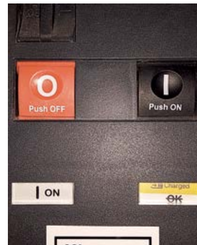
Figura 14 - Disjuntor ligado (ON branco) e mola carregada (Charged amarelo)
