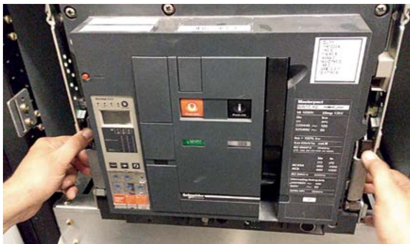
Figura 18 - Posicionamento antes da extração
