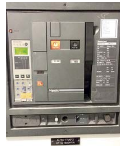
Figura 6 - Disjuntor 07 Auto Trafo AT 1A 1500kVA
