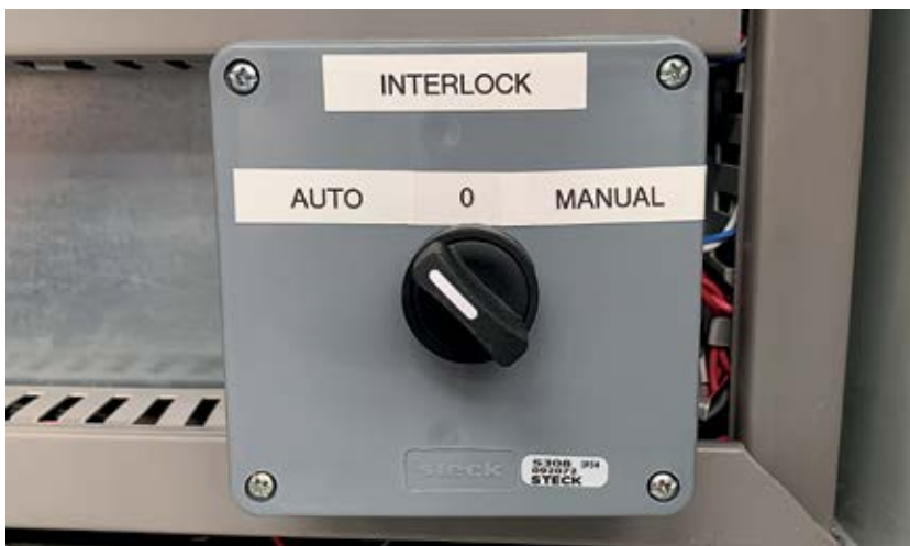
Chave Interlock - No quadro de automação da cobertura
