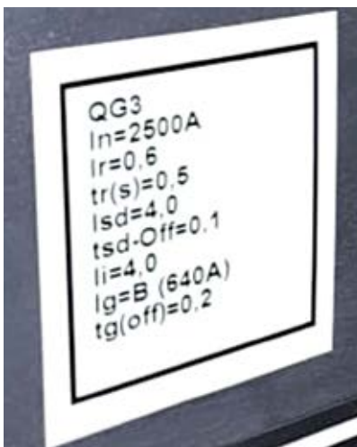
Figura 28 - Etiqueta do ajuste de seletividade nos disjuntores
