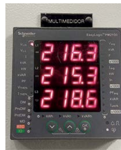
Figura 63 - Display Multimetador
