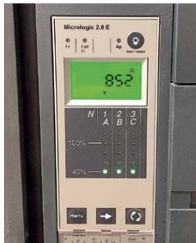
Figura 12 - Display dos disjuntores das câmaras transformadoras indicando presença de corrente exemplo na fase 1 (R) 852A
