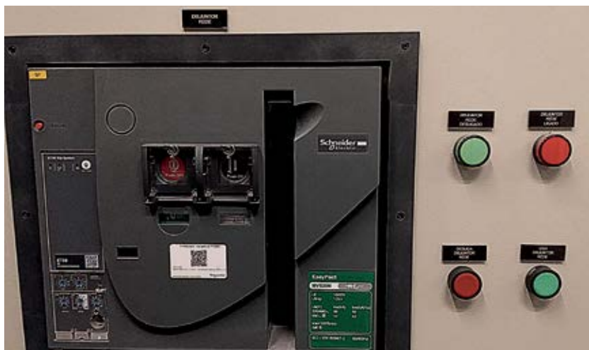
Figura 60 - Disjuntor saída de rede para QTA-1 no QTM-2
